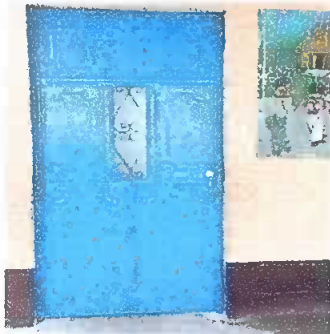
FOTO 3: SUSTITUCION DE PUERTA DE METAL
